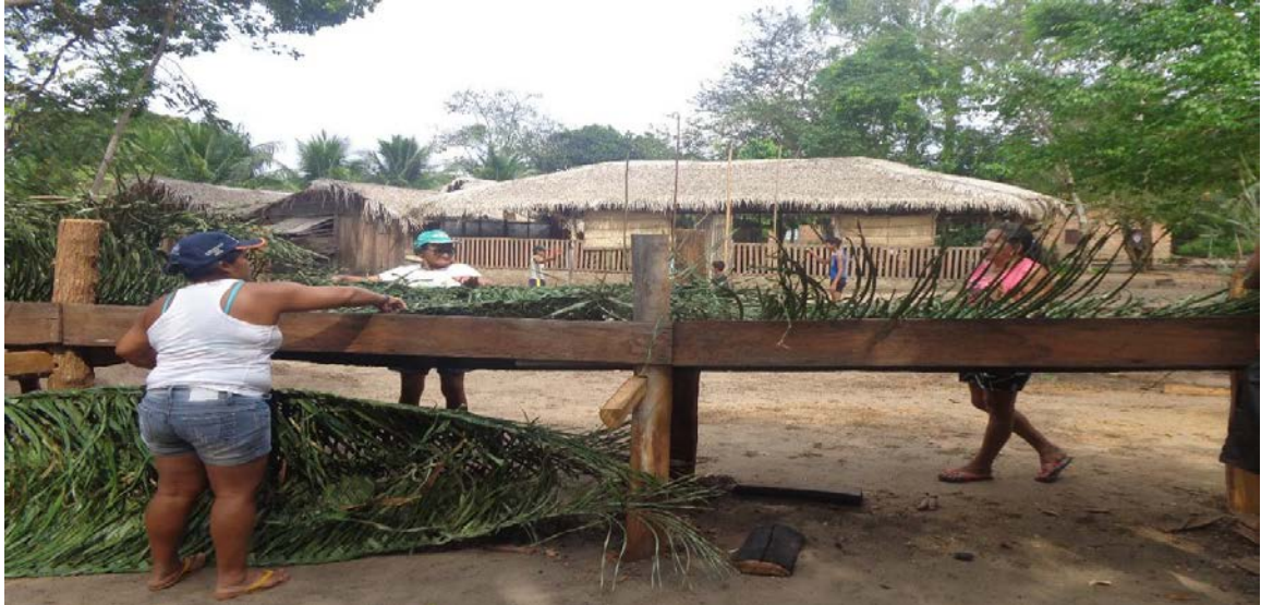
Foto 11: Forro com japa no fundo do canteiro
