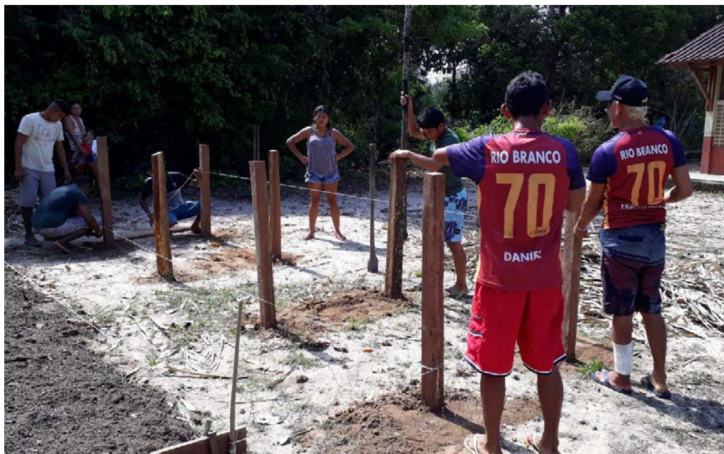
Foto 13: Construção da estrutura da horta suspensa
