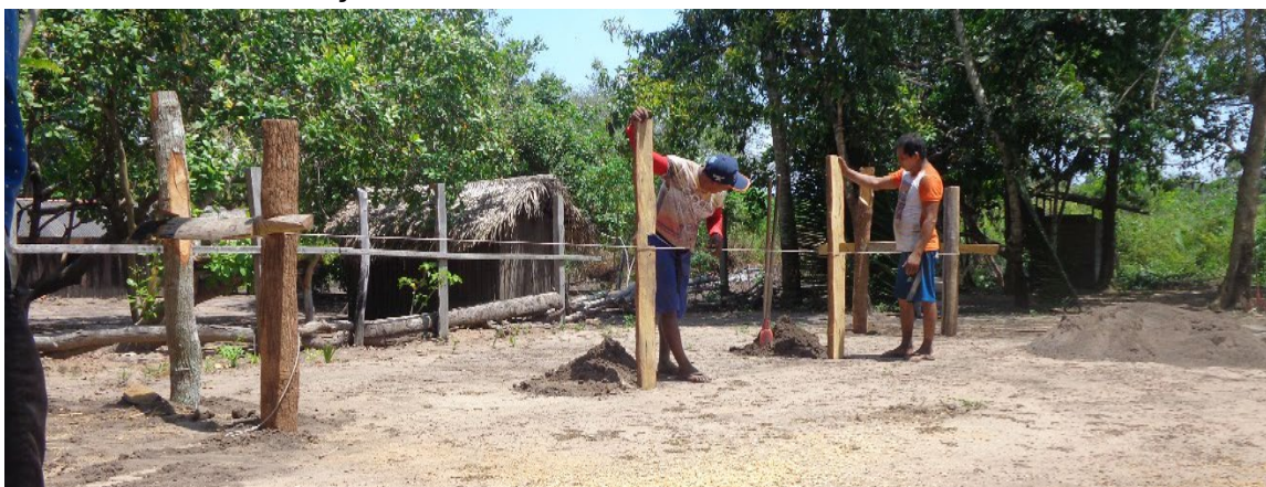
Foto 9: Balcão em construção
