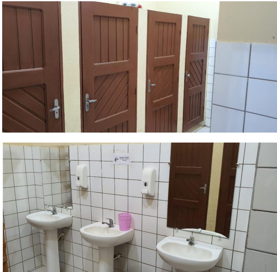
Figura 23. Imagens do banheiro do CMAL. Devido ao pequeno tamanho, deverão ser utilizados por apenas um usuário a cada vez.
