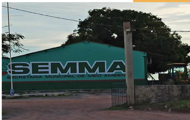
Figura 8: Prédio atual da SEMMA localizado na sede do município de Monte Alegre. Fonte: Téo Frank
