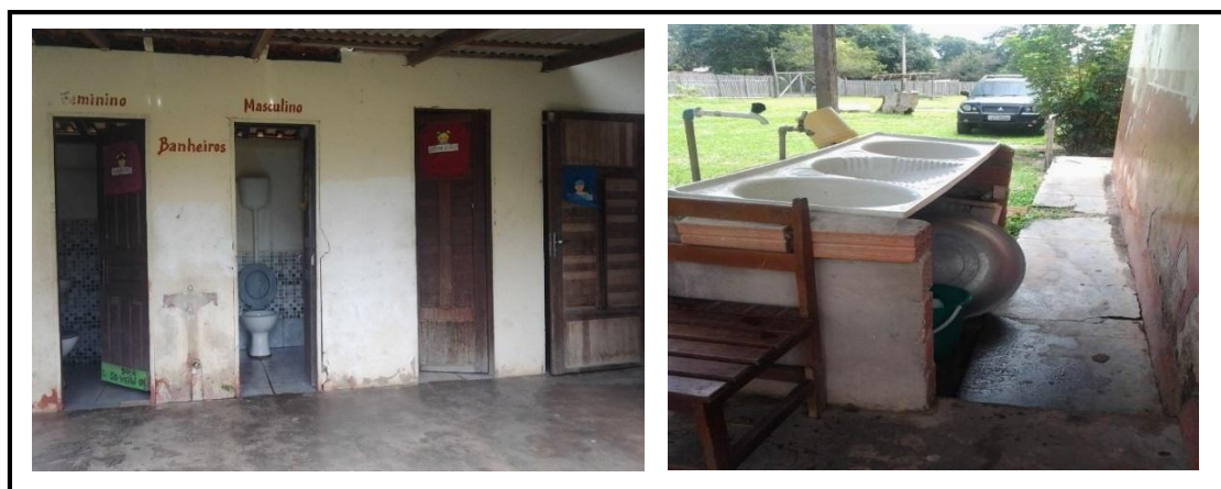
Figura 13 - Imagem do Banheiro e área de serviço
