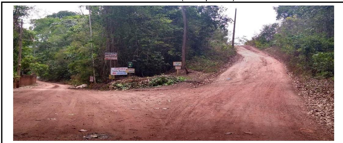
Figura 15 - Entrada da comunidade Vila Nova no Ramal Serra Grande (à direita) e entrada do Ramal da Baronesa e Mulata (a esquerda)
