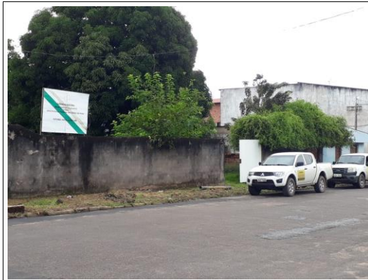
Imagem 3. Vista frontal do Imóvel (17.05.2019)
