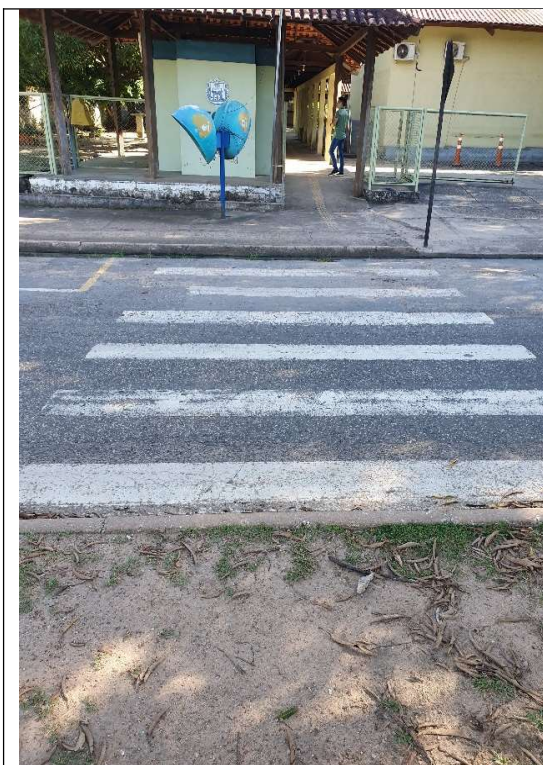
Imagem 4- Ausência de guia rebaixada na faixa de pdestre
