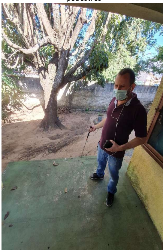
Imagem 7 - Rota de acesso com altura acentuada sem guarda-corpo
