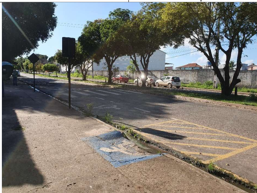
Imagem 3 – Rampa de acesso a calçada desnivelada com o nível da rua e interrompida pela sarjeta
