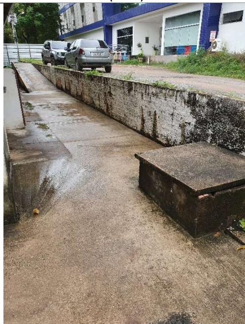
Imagem 22 – Obstrução na calçada e rampa fora dos padrões da ABNT para acesso ao BMT
