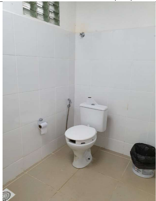
Imagem 25 - Ausência de barras na bacia sanitária em banheiro acessível no BMT
