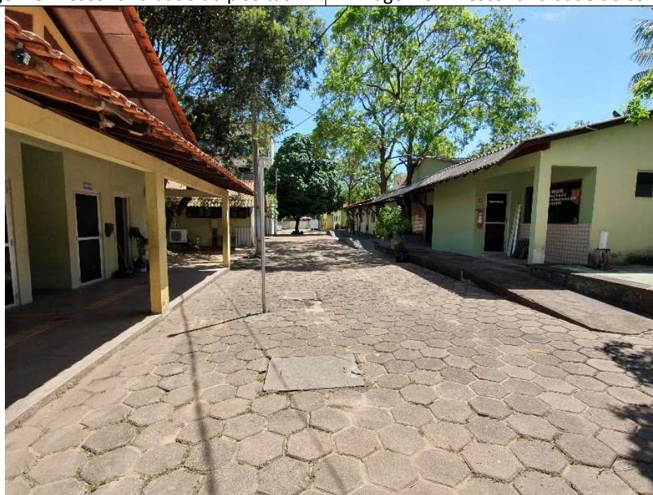
Imagem 10 – Ausência de rampas, piso tátil, estável e não trepidante na circulação externa do campus
