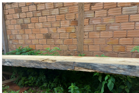
Figura 11: Dano causado pelo impacto lateral em uma peça de piquiá.
